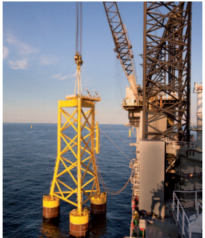
Suction Buckets saugen sich geräuscharm in den Meeresboden. Quelle: DONG Energy
